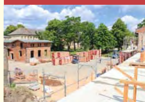
Sommer 2014: Baustelle „Neubau“
