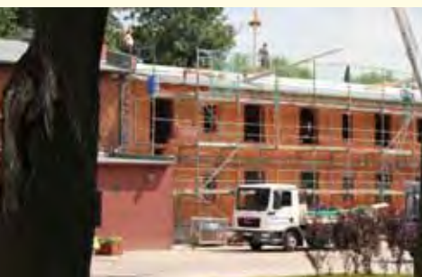
Gleich nach dem Richtfest gingen die Bauarbeiten weiter.
