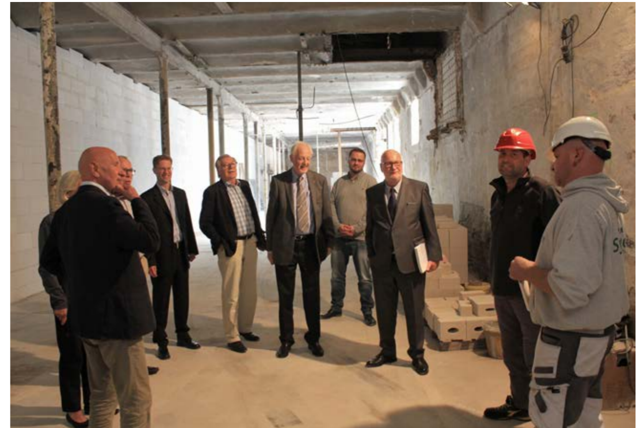
Nach der gemeinsamen Sitzung von Kuratorium und Vorstand am 23. September 2020 mit anschließendem gemeinsamen Mittagessen besichtigen die Mitglieder des Kuratoriums den Baufortschritt des neuen Nachsorge-Wohnhauses. In dem ehemaligen Stallgebäude auf Gut Malchow sollen im Jahre 2021 Wohnbereiche, Lagerräume für die Zweckbetriebe und 12 Wohnungen mit jeweils ca. 50m 2 Wohnfläche für ehemalige Synanon-Bewohner entstehen. Die Nachfrage, so der Vorstandsvorsitzende Uwe Schriever, ist groß. Anmeldungen liegen bereits für alle Wohneinheiten vor.
