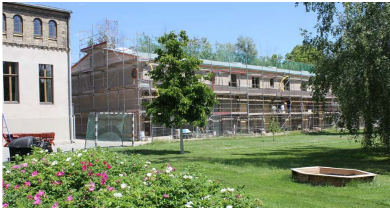
Im Sommer 2020 noch im Bau: In dem ehemaligen Stallgebäude auf Gut Malchow entstehen neben Wohnbereichen und Lagerräumen auch 12 Nachsorge-Wohnungen mit einer Größe von 50 qm bis 60 qm. Die Fertigstellung ist für das Jubiläumsfest „50 Jahre Synanon“ im Jahre 2021 geplant. Damit wird dann auch das letzte marode Gebäude auf Gut Malchow nach nunmehr knapp 7 Jahren saniert sein.
