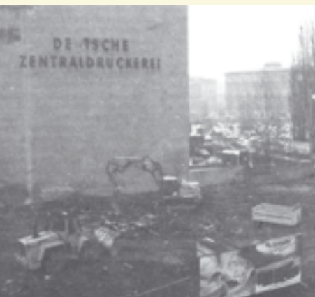
Gegenüber der Bernburger Straße 24 wird die Baugrube für das neue Haus Bernburger Straße 10 ausgehoben.
