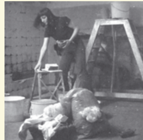
Renovierungsarbeiten in der Oranienstraße 175. Zur Gemeinschaft gehören fünf Erwachsene und ein Kind.
