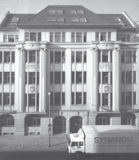
Endlich fertig. Die neue alte Fassade ist ein Werk der Denkmalpfleger. Der Schwerpunkt der Synanon-Transporte liegt jetzt beim Umzugsverkehr. Umzugs-Lkw vor dem Haus Bernburger Straße 24.
