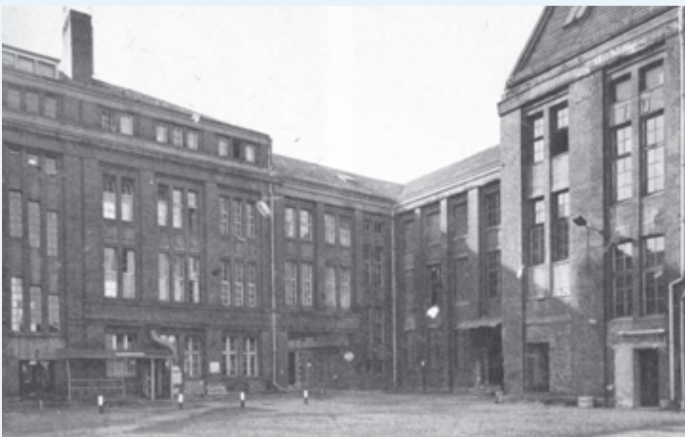
Das Haus Herzbergstraße 82 - 84 kurz nach dem Erwerb.
