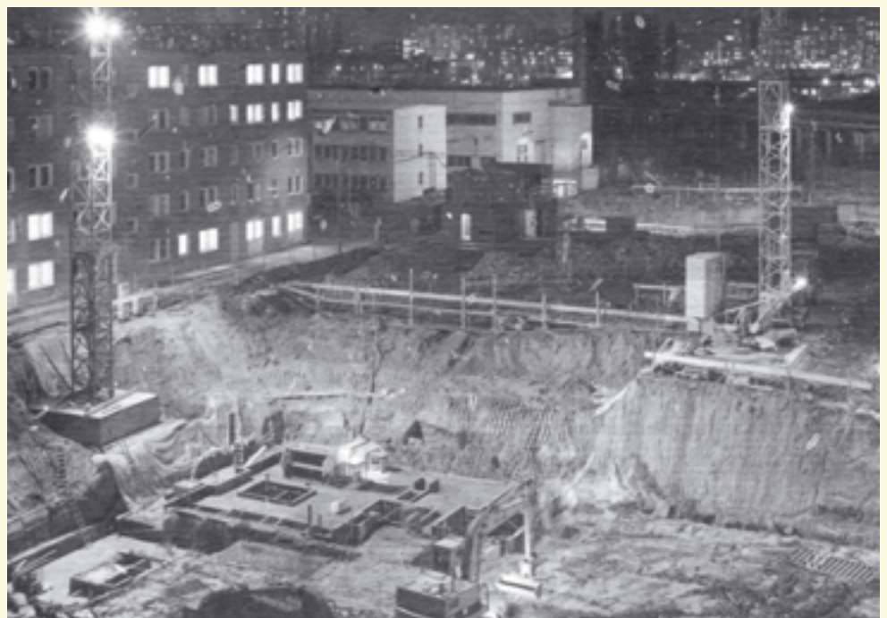
Baugrube für den Neubaukomplex Herzbergstraße in Berlin-Lichtenberg.
