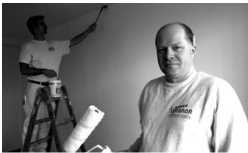
Angelo und Frank auf einer Maler-Baustelle
