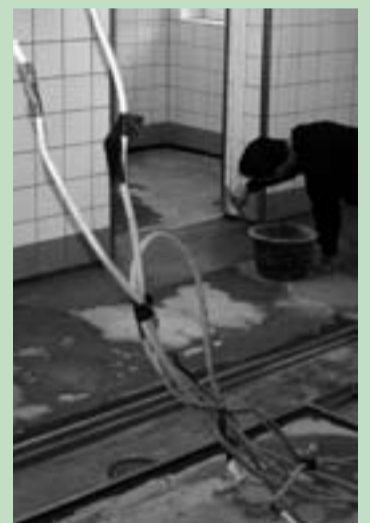
Baustelle Küche: Der Fußboden wurde von Grund auf saniert.
