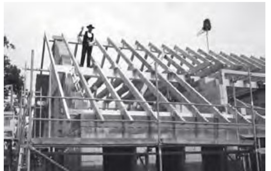
Zimmermann beim Richtfest-Spruch
